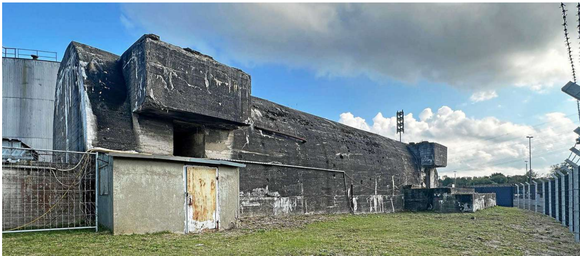
Symbol und Mahnung: Der massive Bunker an der Moorburger Straße.
